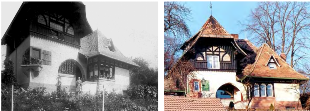
Das von Karl Obenaus 1899 erbaute Wohnhaus in Stadtroda, Töpferberg.
